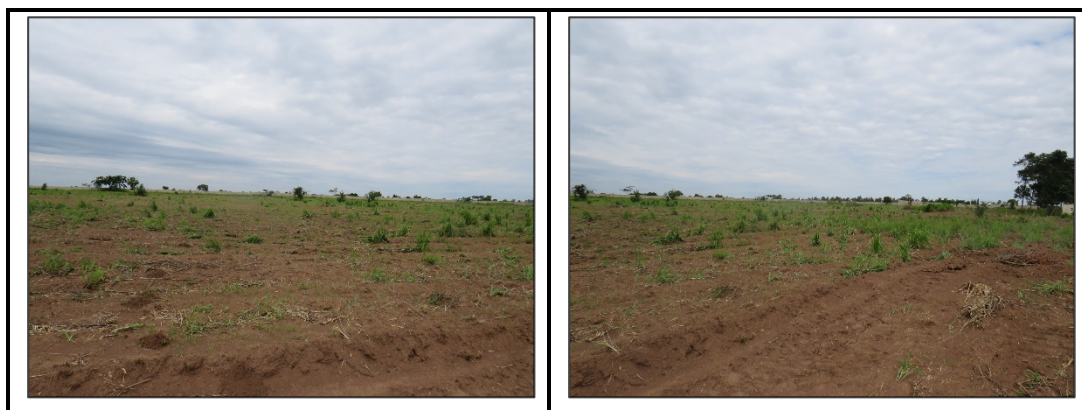
Figura 18- Actividade de remoção da cobertura vegetal do terreno do futuro Centro Regional da Mandioca
